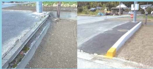
改修前 改修後
