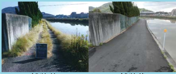
舗装前 舗装後 廬内川排水機場道路舗装
