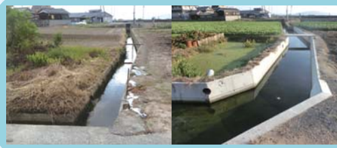
改良前 改良後 久々井西浜水路改良工事
