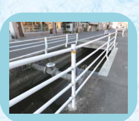
田原用水ガードレール設置
