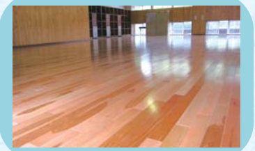
瀬戸中学校武道場床張替え
