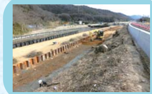
砂川改修柘原工区改修中
