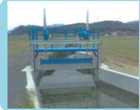
坂根 樋門設置
