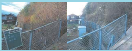
伐採前 伐採後 清野 急傾斜地樹木伐採
