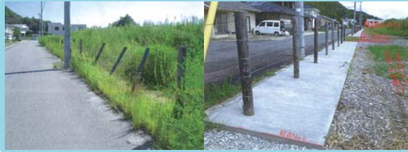
修繕前 修繕後 柘原 砂川防護柵修繕
