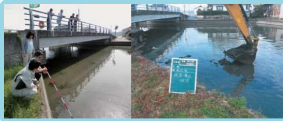
浚渫前調査 浚渫中 清野 幸崎川浚渫
