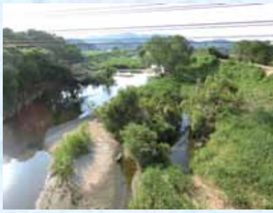
浚渫・伐採前
