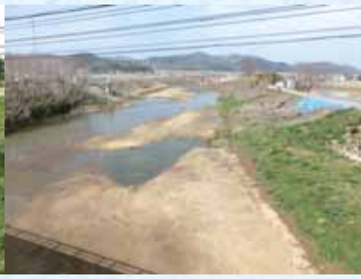
浚渫・伐採後
