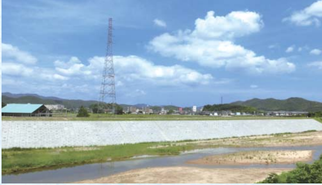
令和2年6月に決壊箇所を含めた槽部橋から砂川橋までの河川改修が完了しました
