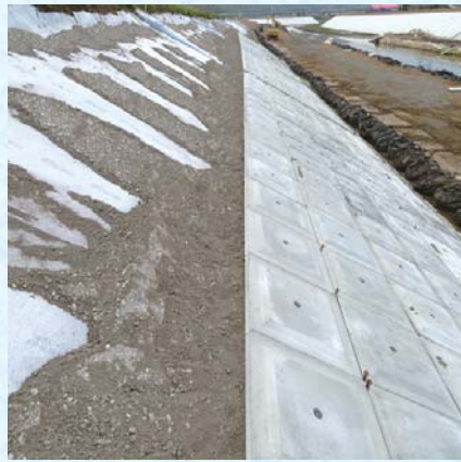
遮水シートとコンクリートブロックを敷き堤防の強度を高めました
