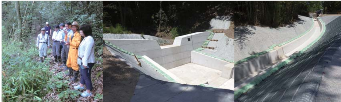
瀬戸町大内 土砂災害対策のための治山ダムを建設
